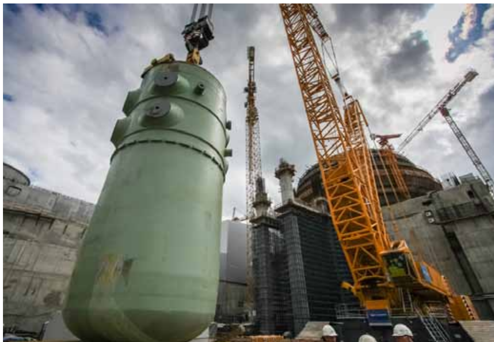
Установка реактора на ЛАЭС-2
