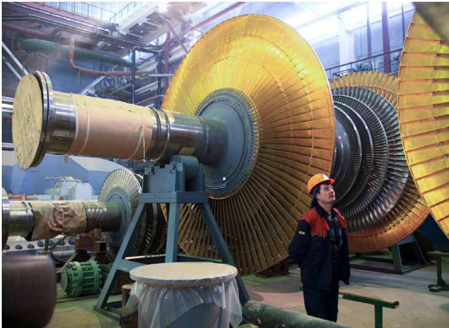
Оборудование Калининской АЭС
