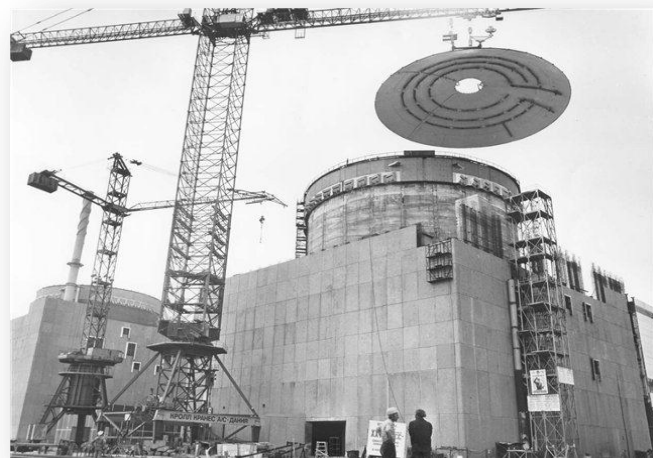
1-я очередь: 1982 г, сборка купола реактора на земле и установка его краном за один подъем
