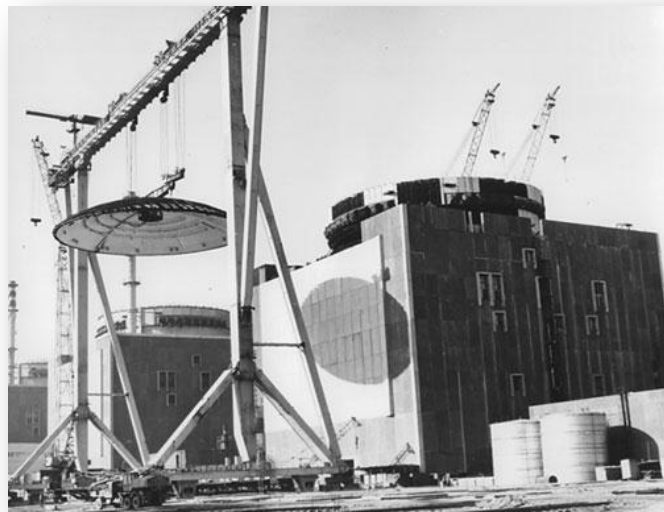
Установка купола со спринклерной системой. Масса 270 т
