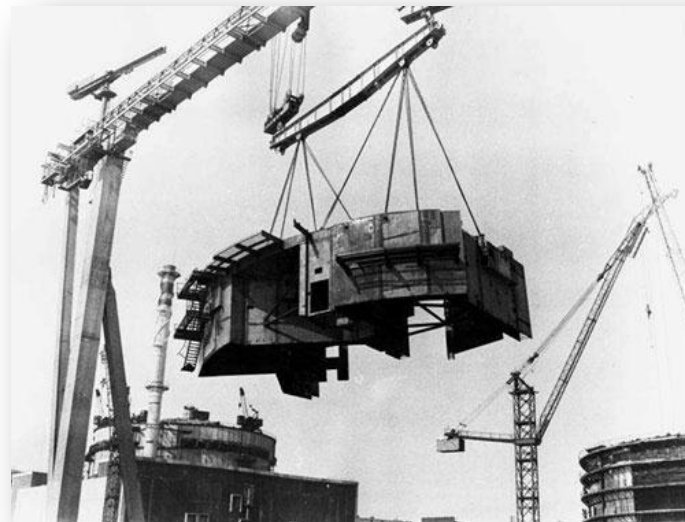
Подъём армокаркаса стен внутригерметичной части помещений. Масса 206 т
