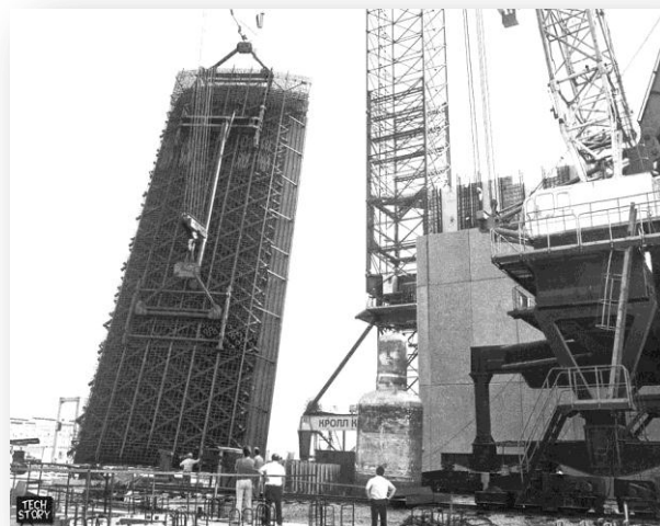
Подъем металлоконструкции гермозоны кранами СКР-3500 и Датским башенным краном KROLL K10000
