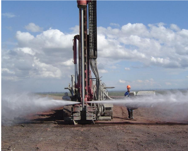
Установка для устройства грунтоцементных свай по технологии Jet grouting
