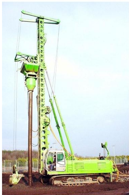
Установка с рабочим органом: виброфлотом
