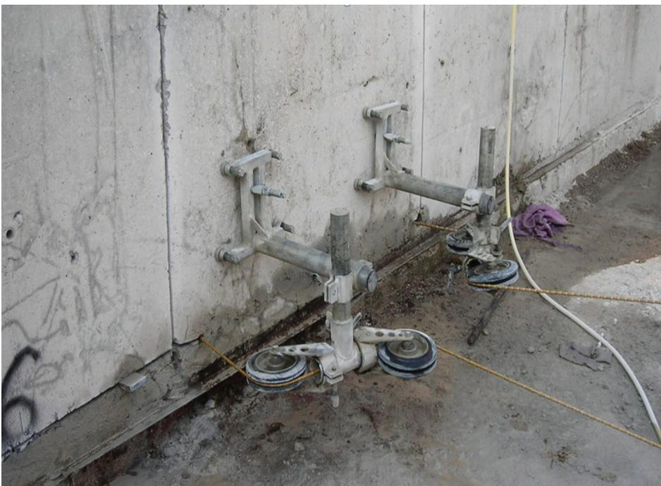
Рис. 4: Горизонтальная резка стеновой конструкции
