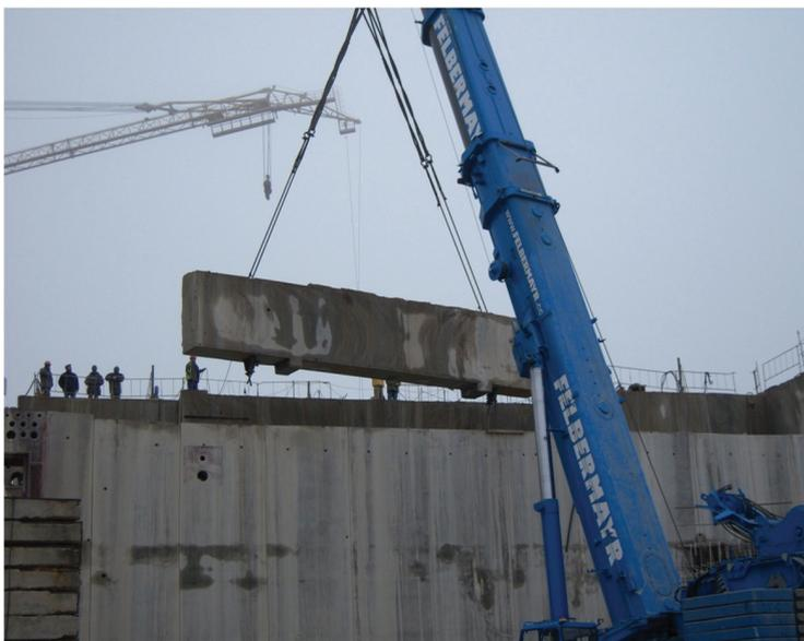
Рис. 6.1: Демонтаж крупного вырезанного железобетонного элемента
