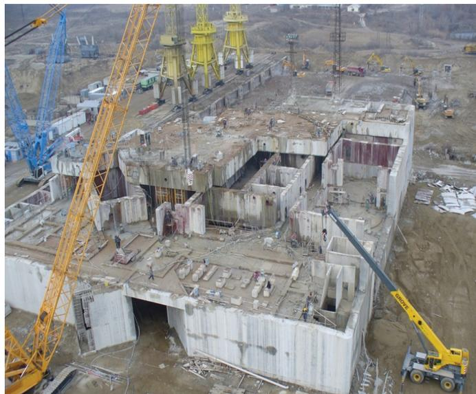
Рис.2: Процесс выполнения демонтажных работ на АЭС «Белене»
