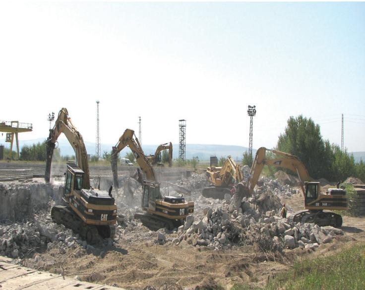
Рис. 5: Разбивание плиты гидромолотами
