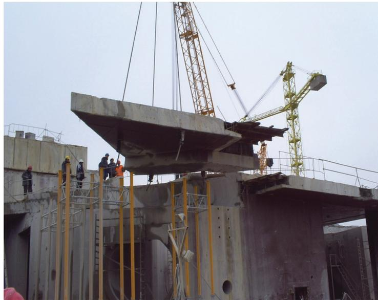
Рис. 6: Демонтаж крупного вырезанного железобетонного элемента
