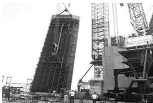
Рис.2: Подъем краном Kroll-10000 фрагмента защитной оболочки в проектное положение с помощью специальной траверсы
