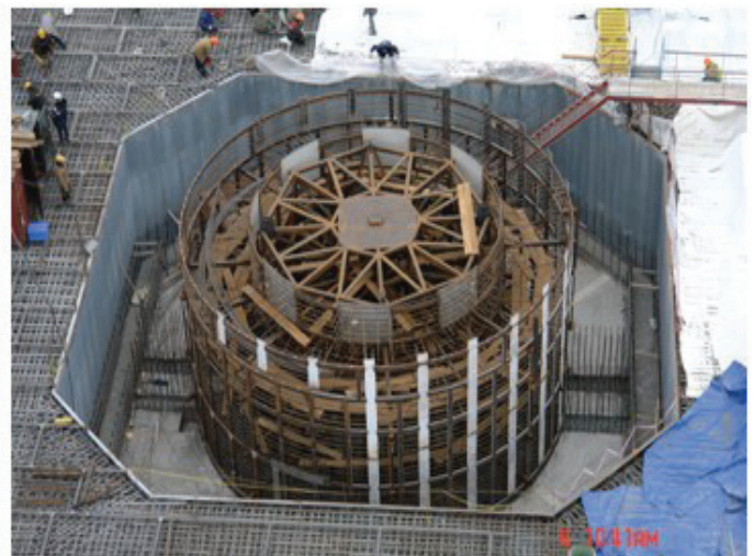
Рис.7: Блок шахты ловушки расплава
