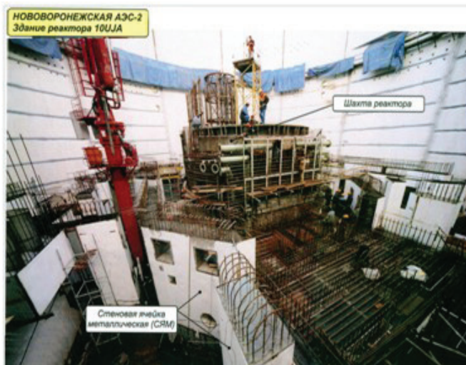
Рис.9: Монтаж блоков ЗЛА
