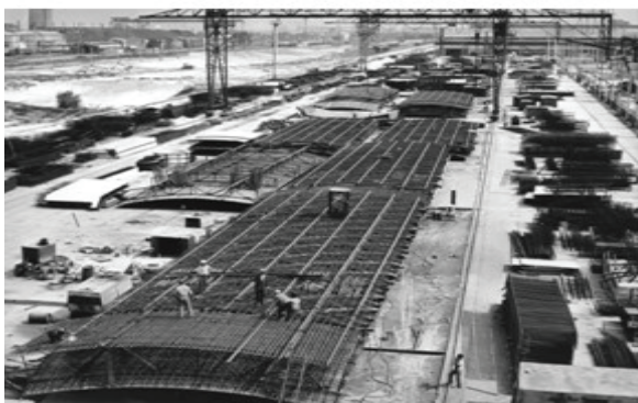
Рис.1: Изготовление на площадке укрупнительной сборки фрагментов защитной оболочки.
