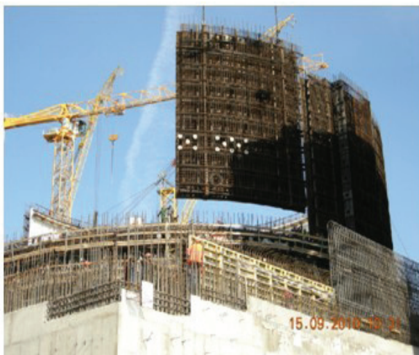
Рис.8: Монтаж блоков защитной оболочки
