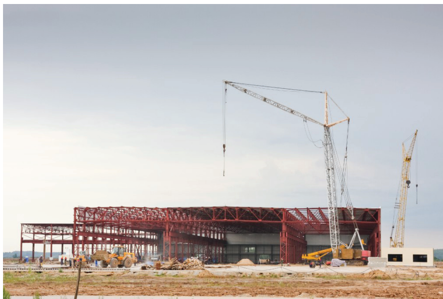
Строительство Балтийской АЭС
