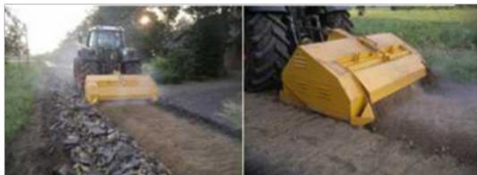
Пройти навесной камнедробилкой на глубину 40 см и переработать старый слой щебня во фракцию щебня 0-15 мм для последующей стабилизации.
