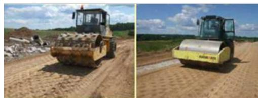
Окончательно уплотнить полученный слой кулачковыми и затем гладковальцовыми катками
