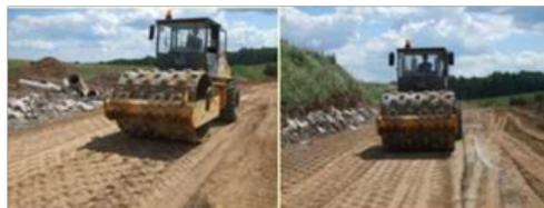
Уплотнить стабилизируемый грунт 16-и тонными кулачковыми виброкатками
