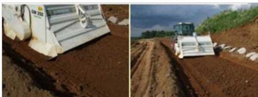
Перемешать полифилизатор «ПГСЖ 1» ресайклером (фрезой) GM 250 на глубину 40 см.
