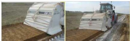
Перемешать внесенные полифилизаторы на глубину 40 см
