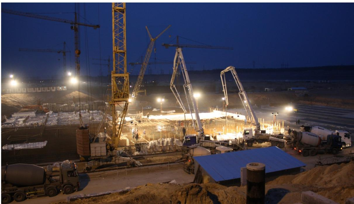
Нововоронежская АЭС-2 Бетонирование фундаментной плиты здания турбины 10UМА
