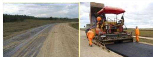
Разлить битумную эмульсию и уложить, асфальтобетон
