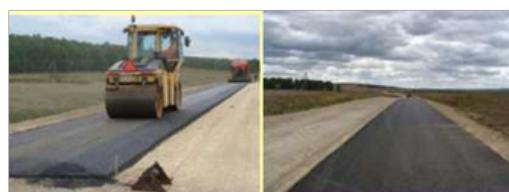
Уплотнить и выровнять асфальтобетон. Подготовить полотно для нанесения дорожной разметки
