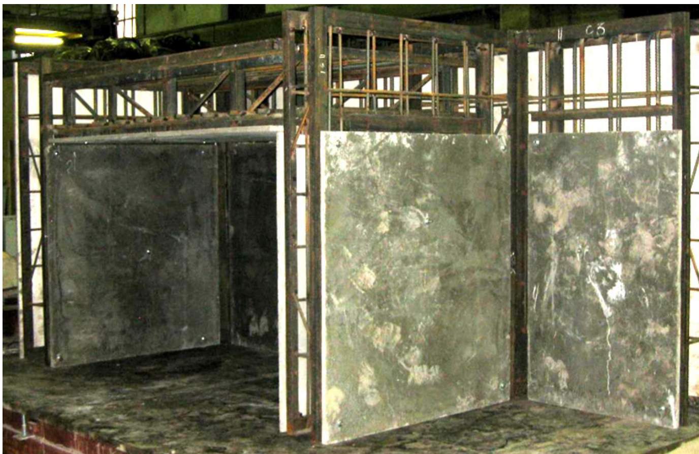
Рисунок 14 – Фрагмент помещения обстройки реакторного отделения, смонтированный с помощью сварки из армоблоков стен и перекрытия с продольными рамами.
