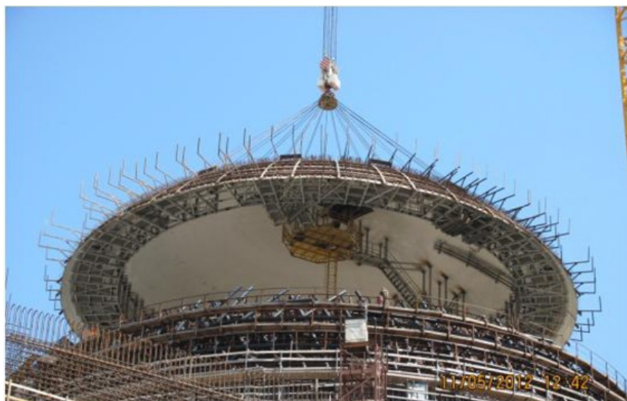
Монтаж блока купола ядерного реактора Нововоронежской АЭС.
