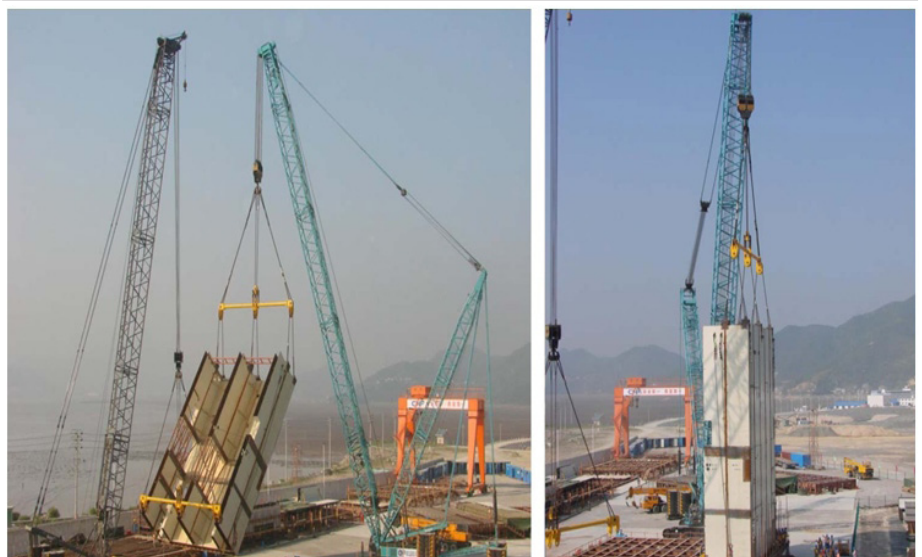
Укрупнительная сборка блока конструкций гермозоны на строящейся по проекту AP 1000 АЭС в Китае
