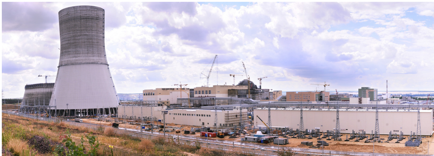
Панорама строительства Нововоронежской АЭС-2 (НВАЭС-2). Сооружение ведется по проекту «АЭС-2006», в котором применена реакторная установка ВВЭР-1200.
