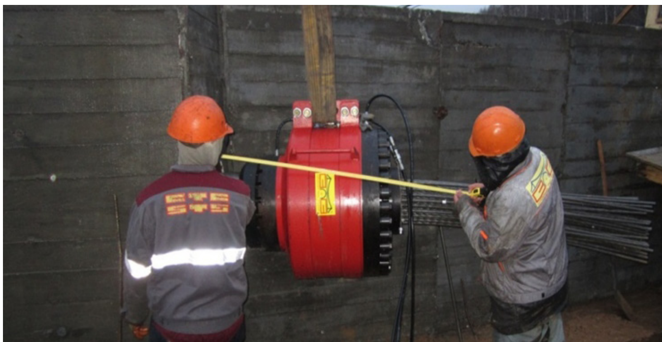
Натяжение армопучка из 55 арматурных канатов на стенде
