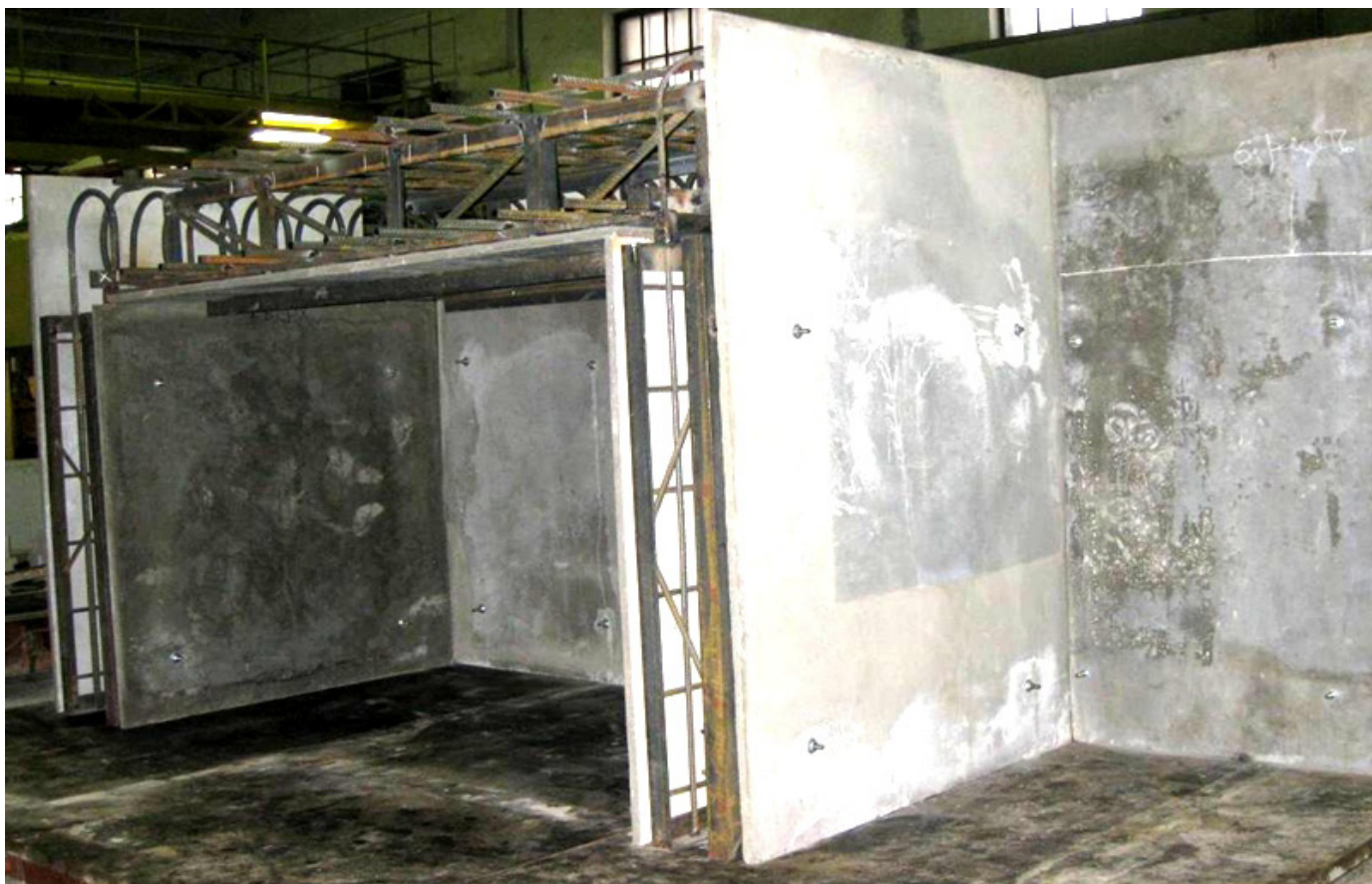
Рисунок 15 – Фрагмент помещения обстройки реакторного отделения, смонтированный с помощью стыков Передерия из армоблоков стен и перекрытия с продольными рамами.
