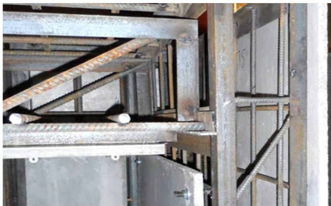
Рисунок 11 – Фрагменты стыков армоблока перекрытия на армоблока стены: а) соединение на сварке, б) соединение с помощью стыка Передерия
