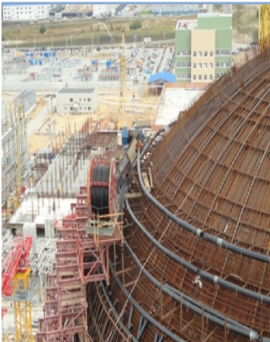
Монтаж армопучков на НВАЭС-2
