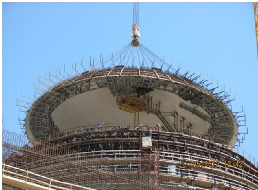
НВАЭС. Монтаж блока купола.
