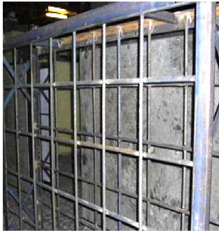
Рисунок 4 - Армокаркас с продольными рамами жесткости
