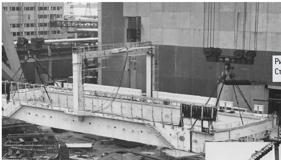
Рис.6 Подъём купола со спринклерной системой. Масса – 270 т. Строповка при помощи специальной системы траверс, используя собственную жёсткость купола. Места строповки и траверсы – ниже вершины купола
