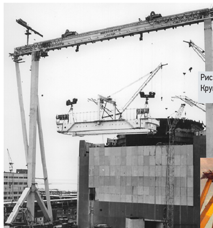
Рис.8 Монтаж купола
