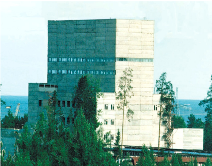
Рис.1 Крупномасштабный контейментный стенд КМС
