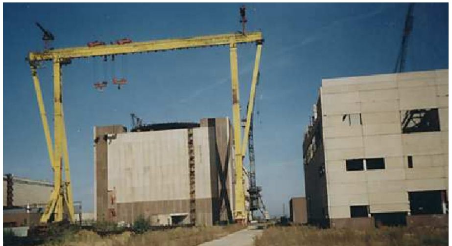
Балаковская АЭС 5 энергоблок. .
