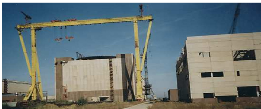
Балаковская АЭС, 5 энергоблок
