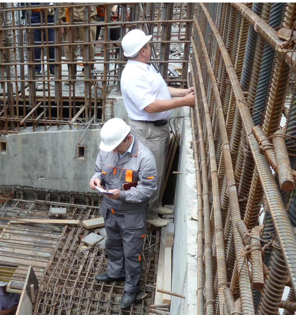
Специалисты отдела технического надзора осуществляют проверку соблюдения норм охраны труда и промышленной безопасности на площадке строительства АЭС
