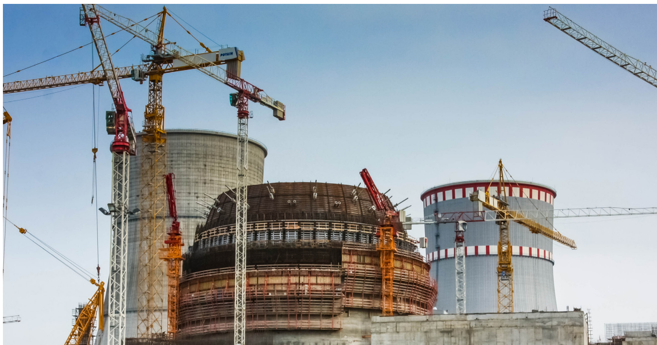
Сооружение Ленинградской АЭС-2
