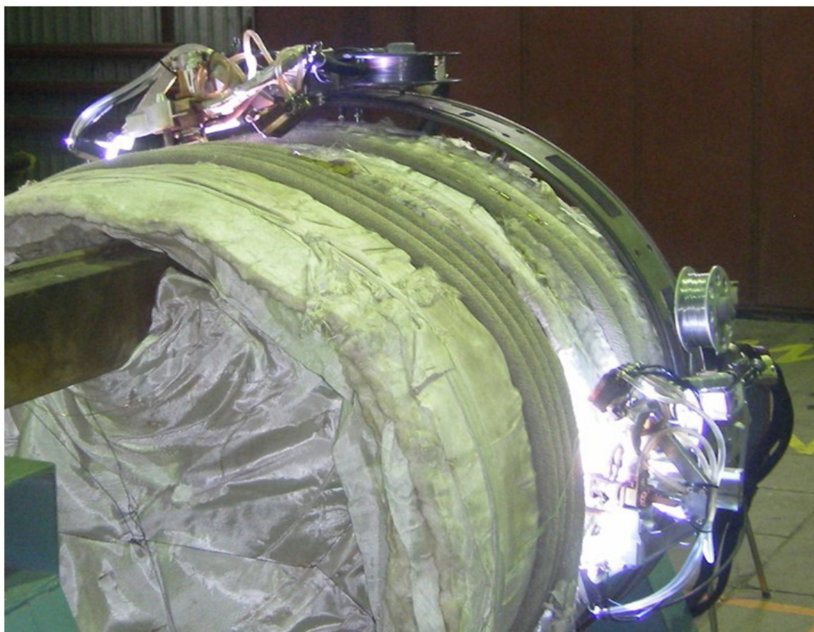
Рис.5 Сварка производственного контрольного соединения ГЦТ двумя комплексами СА-704 одновременно
