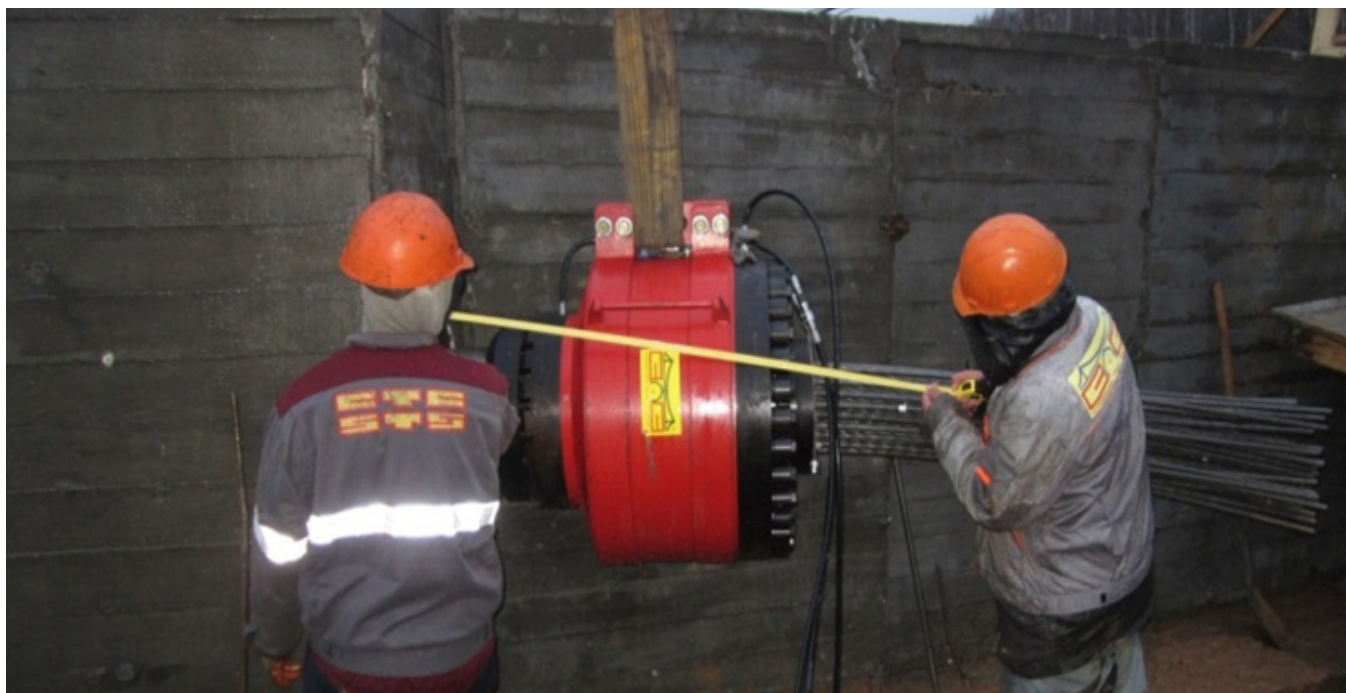
Натяжение армопучка из 55 арматурных канатов на стенде
