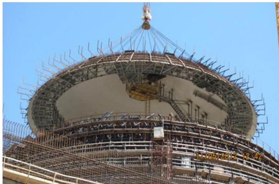
НВАЭС. Монтаж блока купола.
