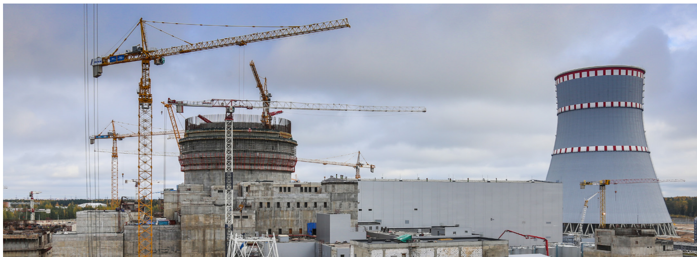
Панорама строительства Ленинградской АЭС-2 (НВАЭС-2).
