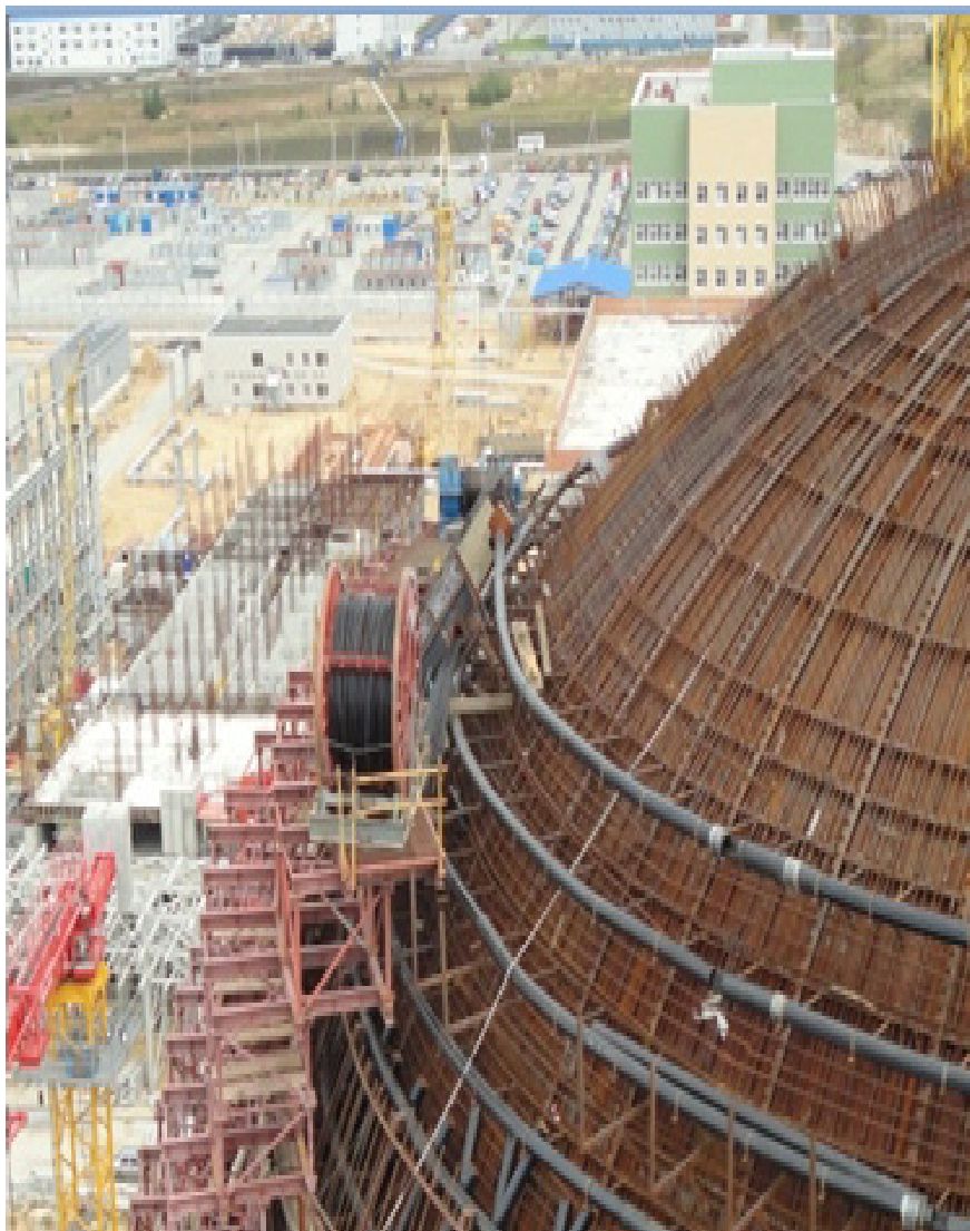
Монтаж армопучков на НВАЭС-2
