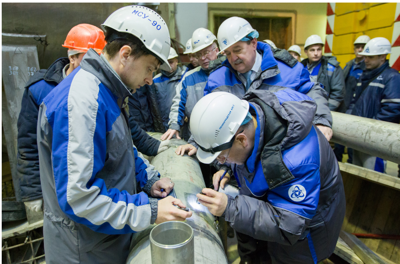
Комплексная выездная проверка отдела технического надзора СРО атомной отрасли на ЛАЭС-2
