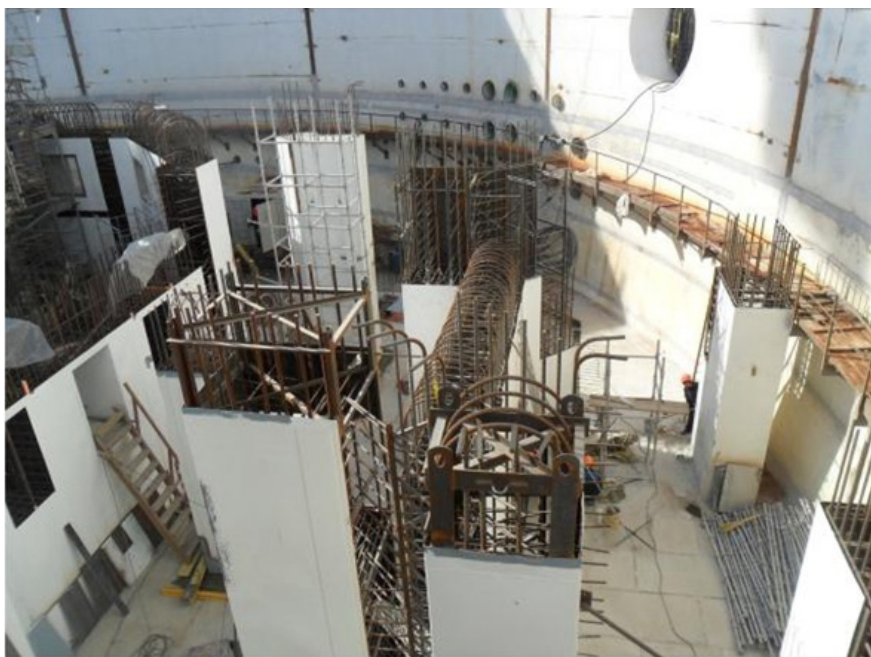
НВАЭС. Монтаж армоопалубочных блоков гермозоны
