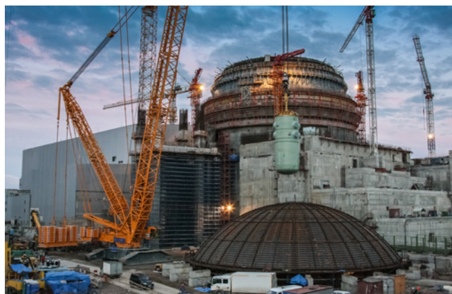
Монтаж корпуса реактора ЛАЭС-2 методом «Open-Top»
